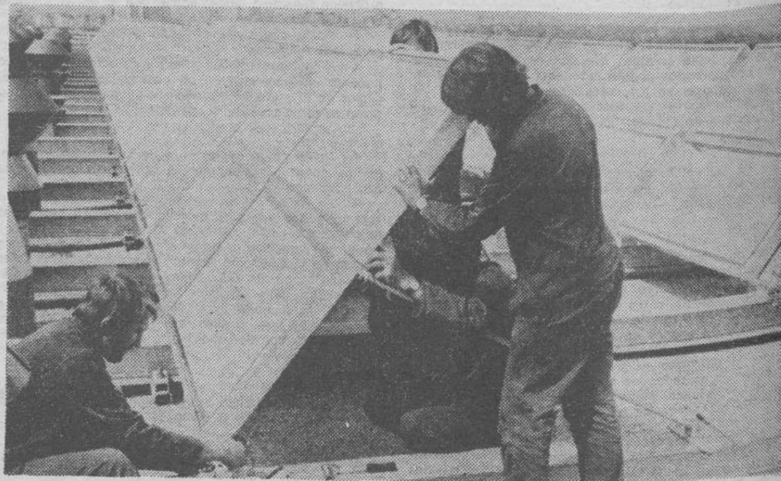
Ciento ochenta y cinco metros cuadrados de paneles solares cubren el edificio del Centro de Investigaciones de la Siemens en Erlangen (Alemania). A través de estos colectores solares se almacenarán diariamente, en un acumulador de diez metros cúbicos, unos 10.000 litros de agua a la temperatura de 55 grados. Esta planta piloto de Erlangen es uno de los más modernos centros experimentales de Alemania. — (Foto FIEL).
