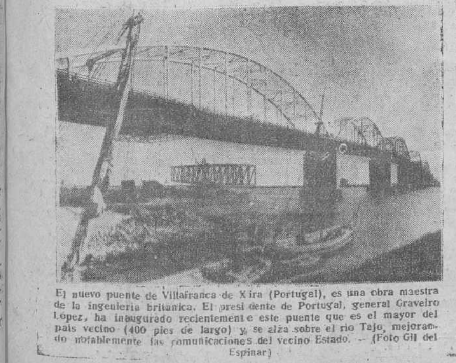
El nuevo puente de Vilafranca de Xira (Portugal), es una obra maestra de la ingeniería británica. El presidente de Portugal, general Gravelo de López, ha inaugurado recientemente este puente que es el mayor del país (400 pies de largo) y se alza sobre el río Tajo, mejorando notablemente las comunicaciones del vecino Estado. (Foto Gil del Espinar)
