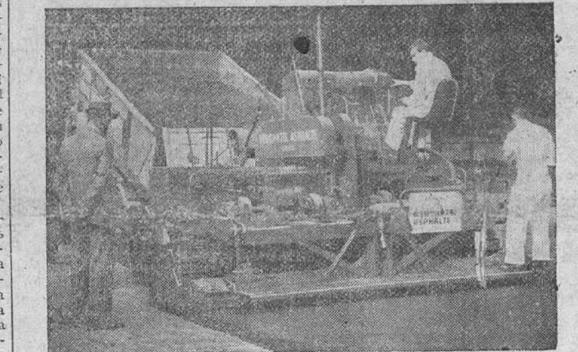
Esta máquina que se utilizó para construir aeródromos durante la guerra, se emplea ahora en Inglaterra para el trazado de nuevas carreteras. Esparea el asfalto de manera uniforme y lo iguala cualquiera que sea la desigualdad del suelo. A medida que avanza va dejando la calzada ya terminada.—(Foto Cifra)
