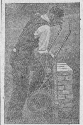
Carretilla para el transporte de ladrillos preparados. Moviendo una palanca se cargan 40 ladrillos cada vez. (Foto CALPE)
