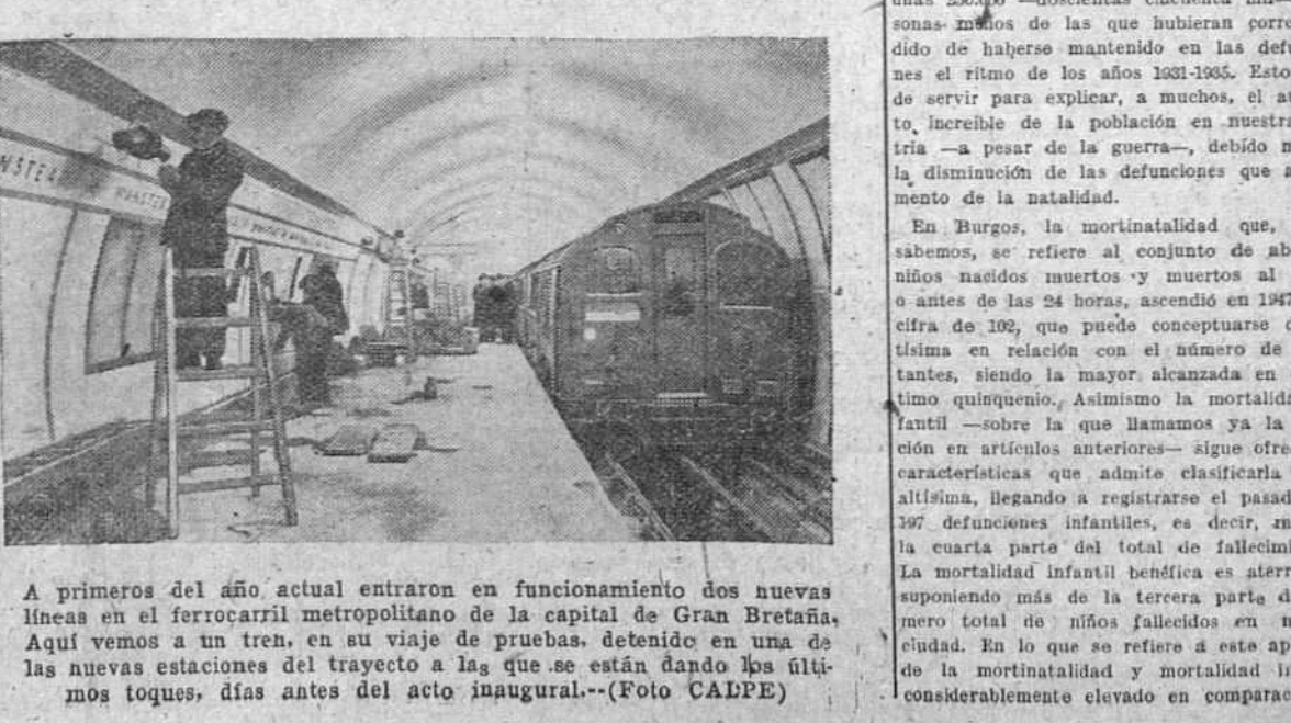
A primeros del año actual entraron en funcionamiento dos nuevas líneas en el ferrocarril metropolitano de la capital de Gran Bretaña. Aquí vemos a un tren, en su viaje de pruebas, detenido en una de las nuevas estaciones del trayecto a las que se están dando los últimos toques, días antes del acto inaugural.—(Foto CALPE)
