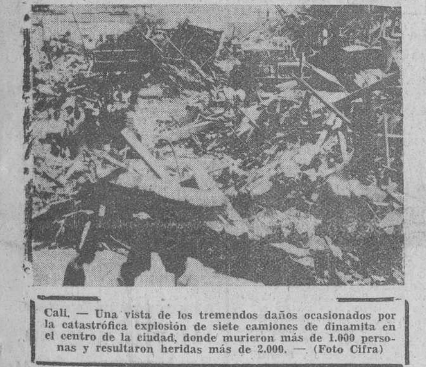
Call. — Una vista de los tremendos daños ocasionados por la catastrófica explosión de siete camiones de dinamita en el centro de la ciudad, donde murieron más de 1.000 personas y resultaron heridas más de 2.000. — (Foto Cifra)
