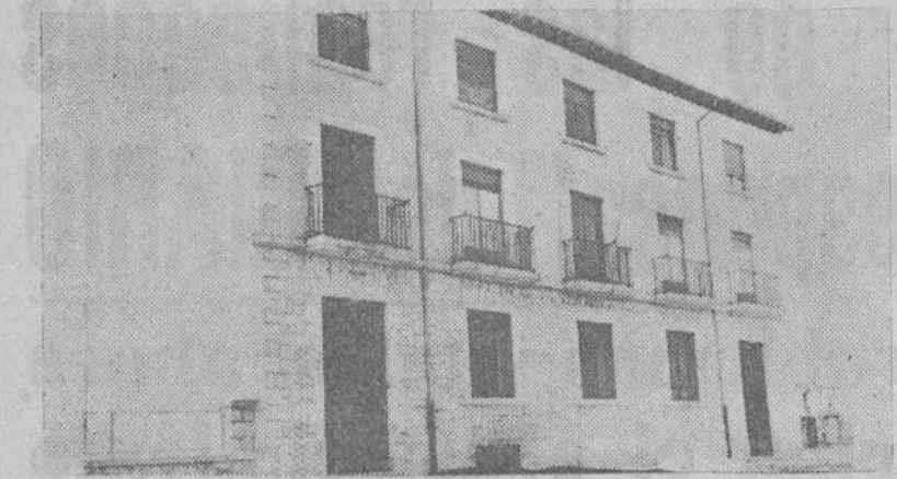
EDIFICIO DONDE SE HALLA INSTALADA LA DELEGACION DEL INSTITUTO NACIONAL DE PREVISION. — (Foto García)
