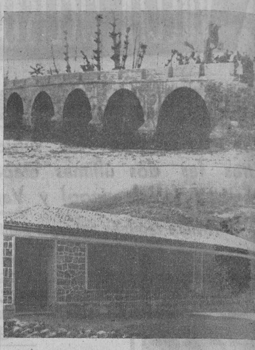
En nuestro grabado se reproduce el sólido puente inaugurado ayer tarde por el gobernador civil en el pueblo de La Revilla...
