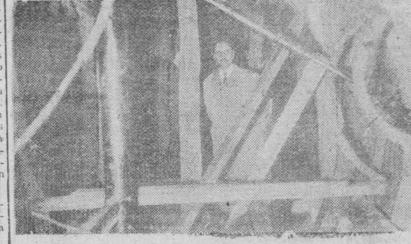
En cuarta pagina publicamos un reportaje acerca de la aplicación por primera vez en Espana, en las obras del colector Norte de nuestra ciudad, de un nuevo procedimiento para el fraguado del hormigón. Las pruebas se han efectuado con exito, a presencia del alcalde de la ciudad, que aparece en el grabado, bajo el molde plegable, que es una de las características más criginales del aludido precedimiento. -- (Foto Fede)
