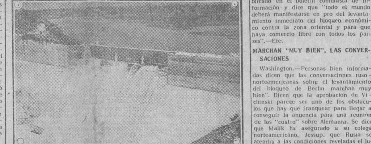
Una vista del estado actual de las obras del Pantano de Alarcón, con capacidad para 700 millones de metros cúbicos y al cual sólo faltan los últimos toques para su terminación. (Foto CIFRA GRAFICA)
