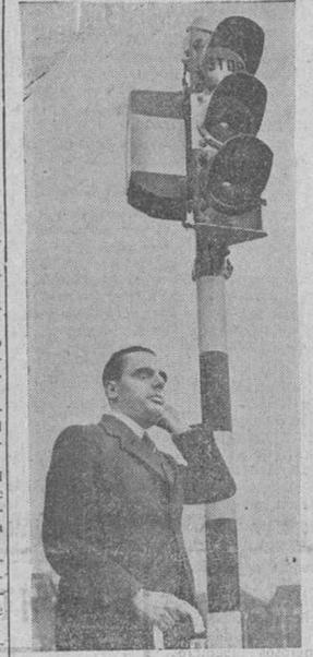
Se ha inventado un dispositivo que, acoplado a los puestos reguladores de tráfico para peatones, transmite las señales de "parada" o "cruce ahora" en forma sonora.
