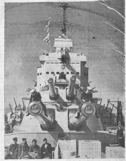
Una vista de la cubierta del nuevo acorazado británico "Vanguard", botado recien emente. Desplaza 45.000 ton dadas, tiene 15 cañones de grueso calibre y lleva una tripulación de 2.000 hombres. (Foto Calpe).
