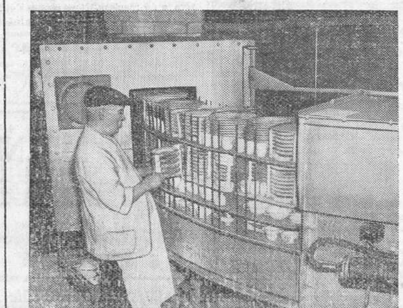
La industria británica de alfarería, recobra rápidamente el nivel normal de producción. Más de 300 fábricas existen en Inglaterra dedicadas a la cerámica. Aquí vemos a un obrero de las factorías Copelands, al cuidado de un gigantesco horno eléctrico del que va saliendo la vajilla. (Foto Calpe)
