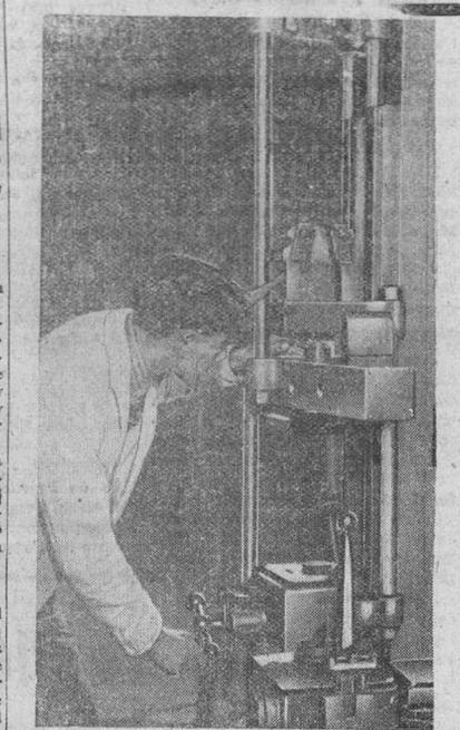
En el laboratorio de una importante alfarería británica, se someten a pruebas de resistencia los recipientes de una máquina especial que ejerce altas presiones sobre la cerámica, antes de lanzar los productos al mercado. (Foto Calpe.)
