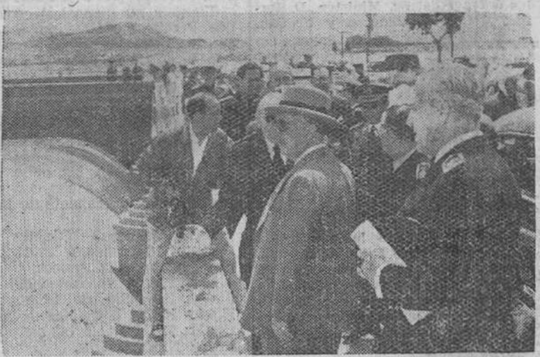
Las Bardenas (Zaragoza). — S. E. el Jefe del Estado, acompañado de los ministros secretario general del Movimiento, Obras Públicas y Agricultura, durante su visita a la zona regable de Las Bardenas, donde visitó el pantano de Yesa y las obras del canal de Las Bardenas. — (Foto Cifra)
