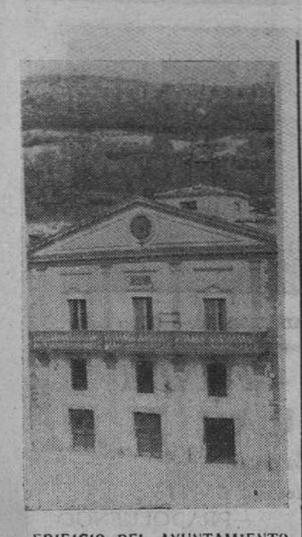
EDIFICIO DEL AYUNTAMIENTO
