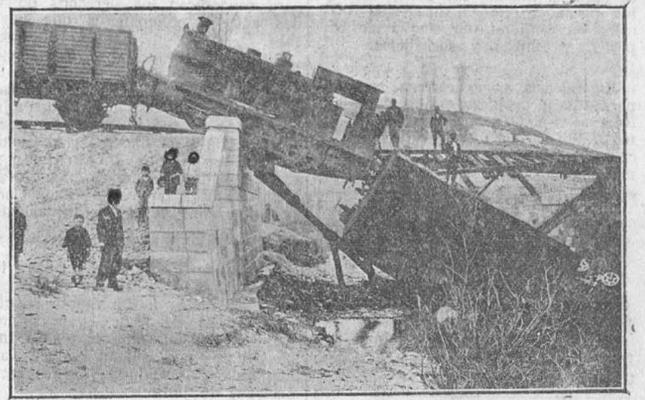
Ayer 28, a la una y veinte minutos de la tarde, al cruzar la máquina del avance, por un puente provisional de los que ha tenido la compañía para paso de material, se rompió una viga de éste, y la máquina quedó colgada, cayendo al río el furgón y la mesilla.
