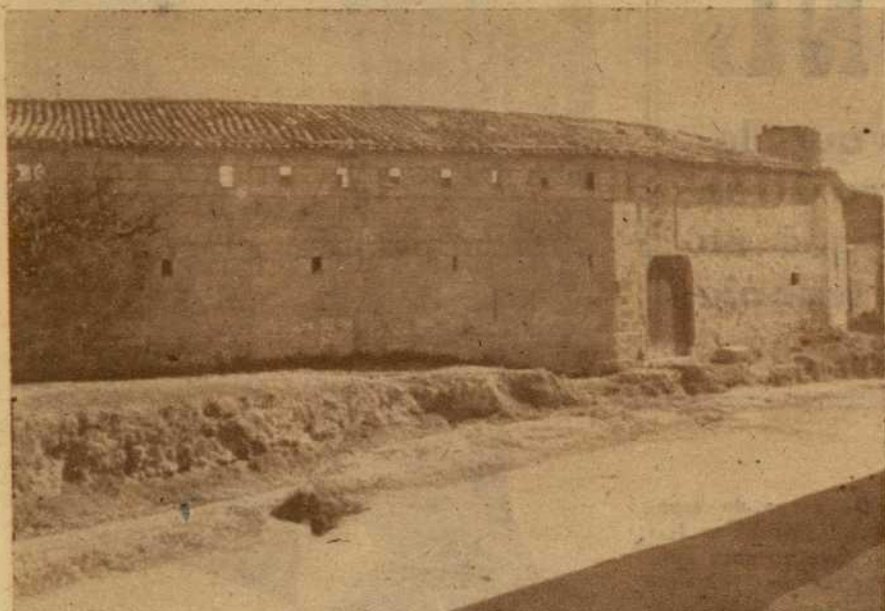
Vista exterior de la Plaza de toros de Inca
