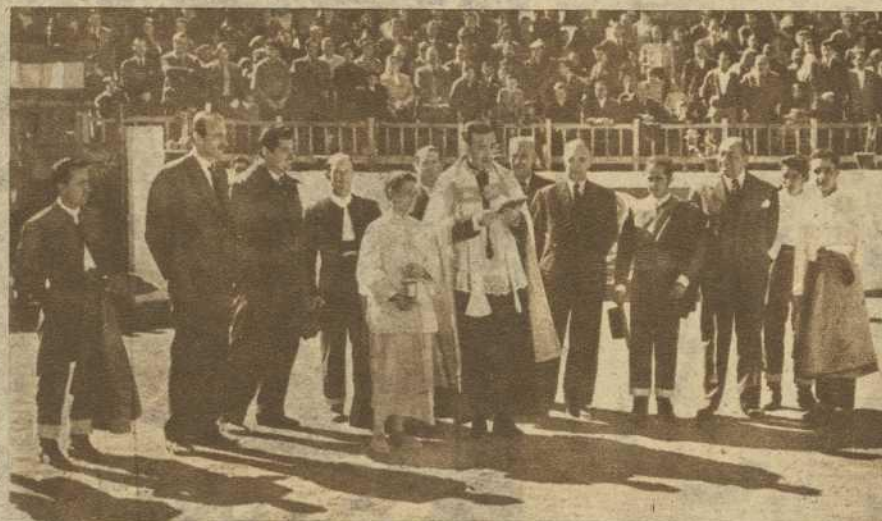
El cura párroco don Emilio Navarro da la bendición a la instalación de la nueva Plaza de toros alicantina, construída para dedicarla exclusivamente a escuela taurina. El nuevo coso taurino, que lleva el nombre de Vista Alegre, cuenta con capacidad para más de dos mil espectadores, y ha sido levantado en el ampuloso barrio alicantino de Los Angeles
