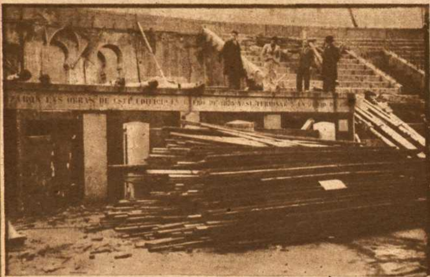
Los chiqueros de la vieja Plaza madrileña, a punto de sentir la fuerza demoleadora de la piqueta
