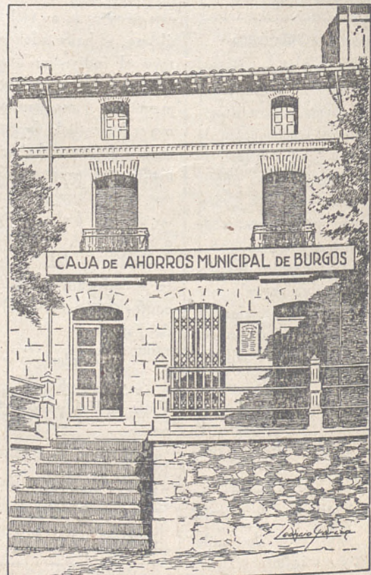
Oficina donde está instalada la Caja de Ahorros Municipal, en Lerma
