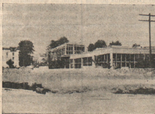
Vista general que ofrecen las obras del Grupo Escolar, paralizadas hace diez meses
