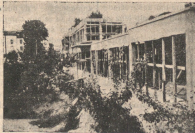
Fachada principal del futuro Grupo Escolar
