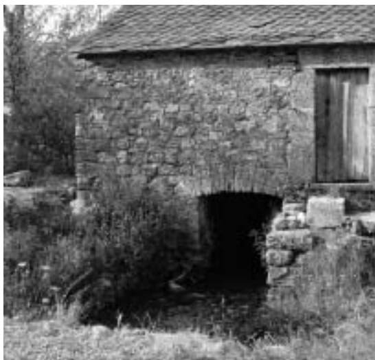
Las construcciones de molinos forman parte de nuestro paisaje provincial, aunque en la mayoría de los casos hayan perdido su uso inicial.
