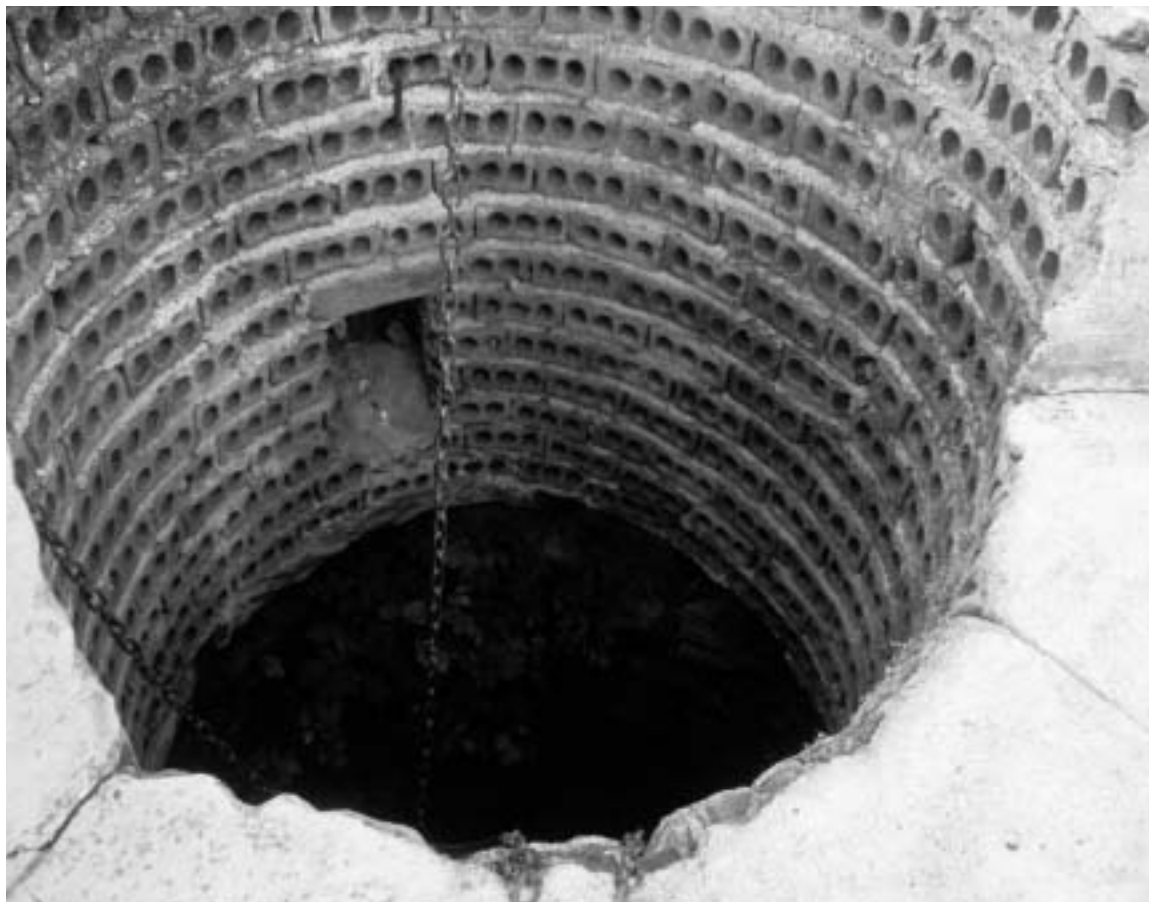
Interior de pozo con las paredes de ladrillo.
