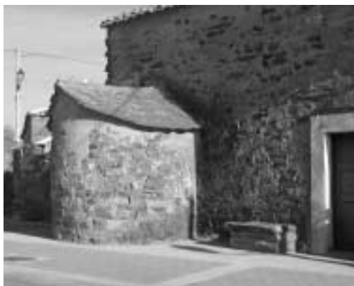
Exterior de un típico horno maragato adosado a la estructura general de la casa.
