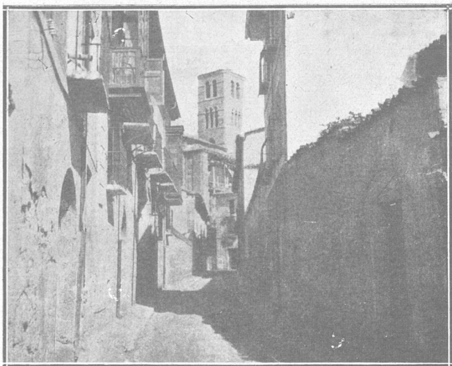
Calle Nueva de San Martín, rincón evocador del Valladolid antiguo
