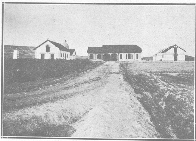
Escuela de Capataces de Palencia.— Vista general
