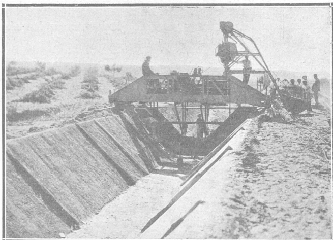
Máquina de revestimiento trabajando en el Canal de San José
