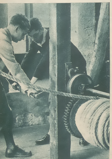
Los baúles de los estudiantes son elevados por el exterior de la torre a través de una polea y por medio de un torno
