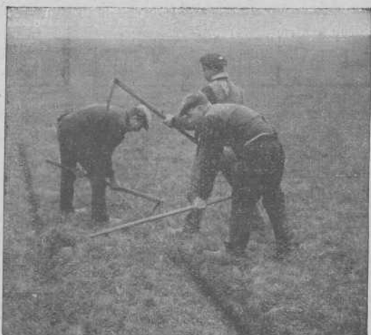
Fig. 95. — Construcción de acequias desbordantes en forma de V Hacienda de M. P. de Malliard, en Saint-Loup-sur-Seimouse (Alto Saona)
