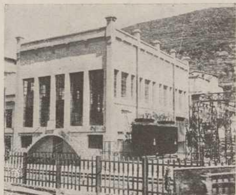
La sub-central elèctrica de Ripoll
