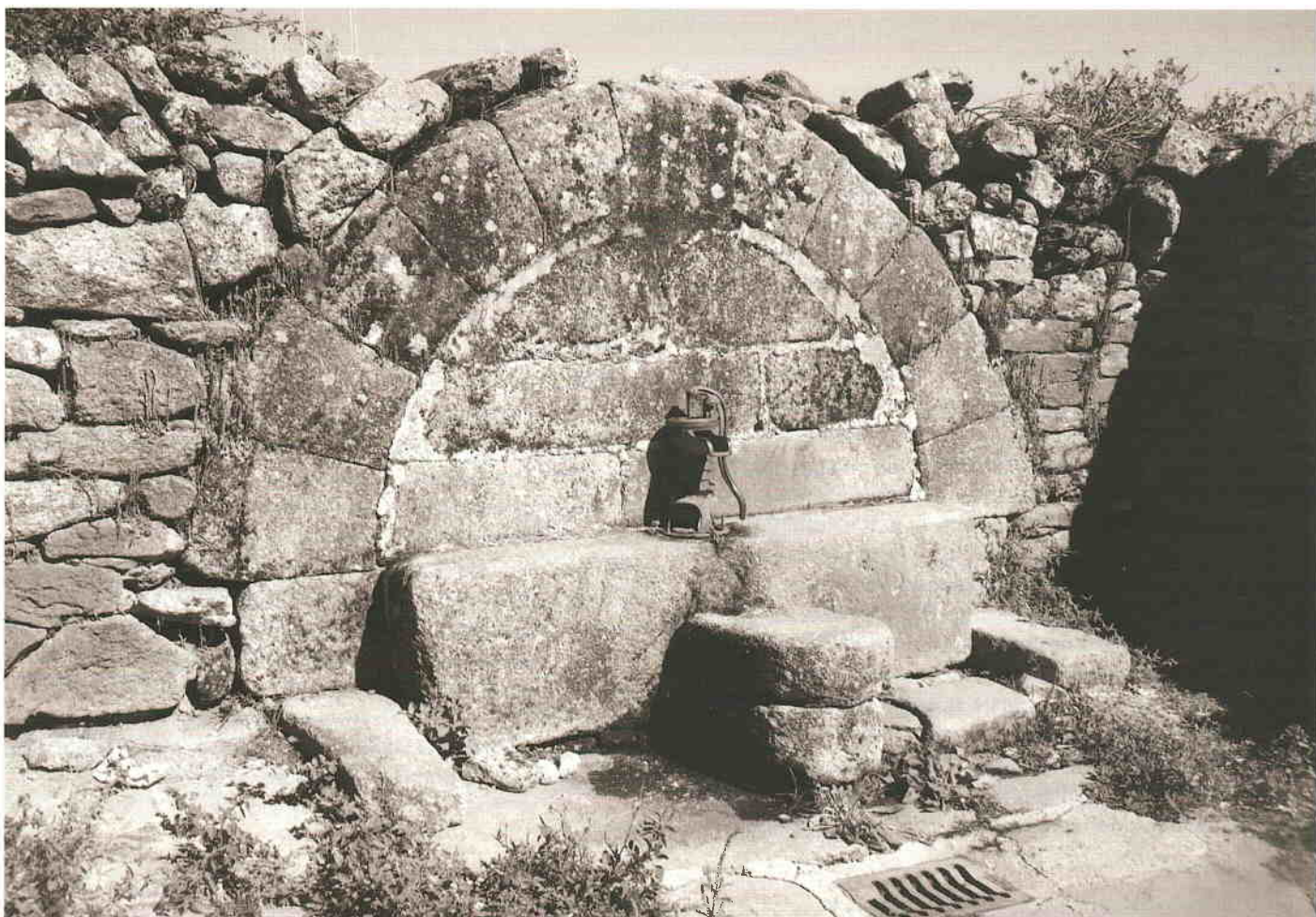
Los últimos eslabones de una larga cadena: fuentes con bóveda de cañón cerrada y bomba de émbolo, construidas en Bermillo de Sayago a fines del siglo XIX (arriba: Pozo Esteban, abajo: La Toza).
