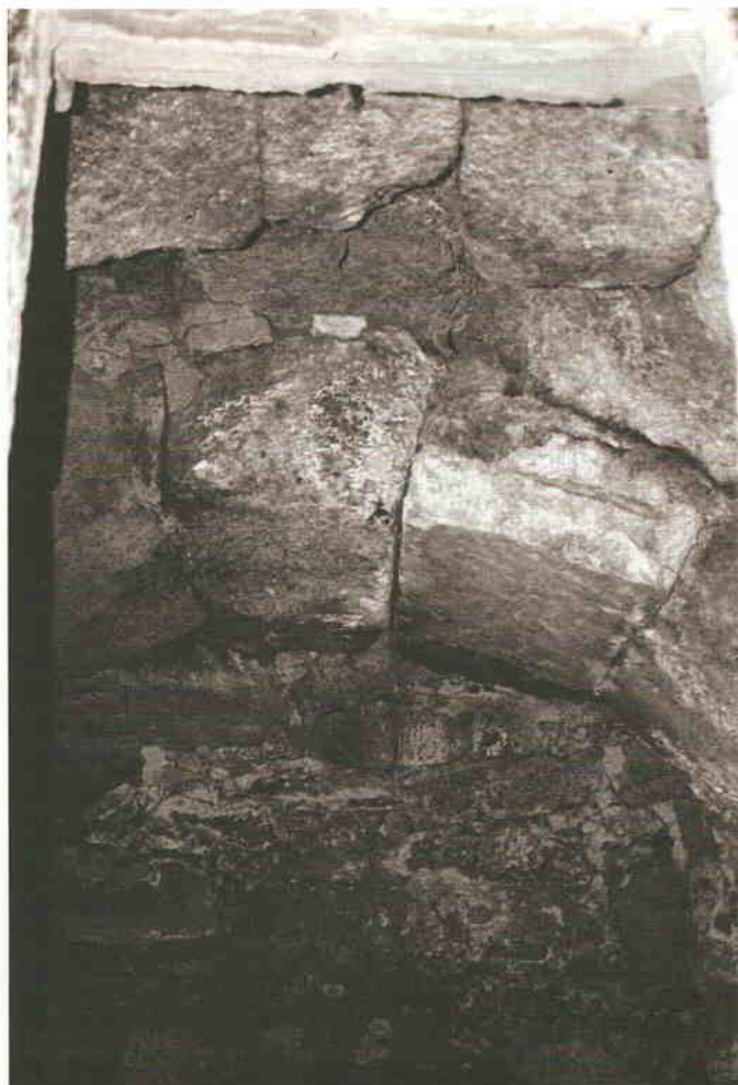
Fermoselle: Fuente la Manzanal. Vista exterior y bóveda con arcos fajones.
