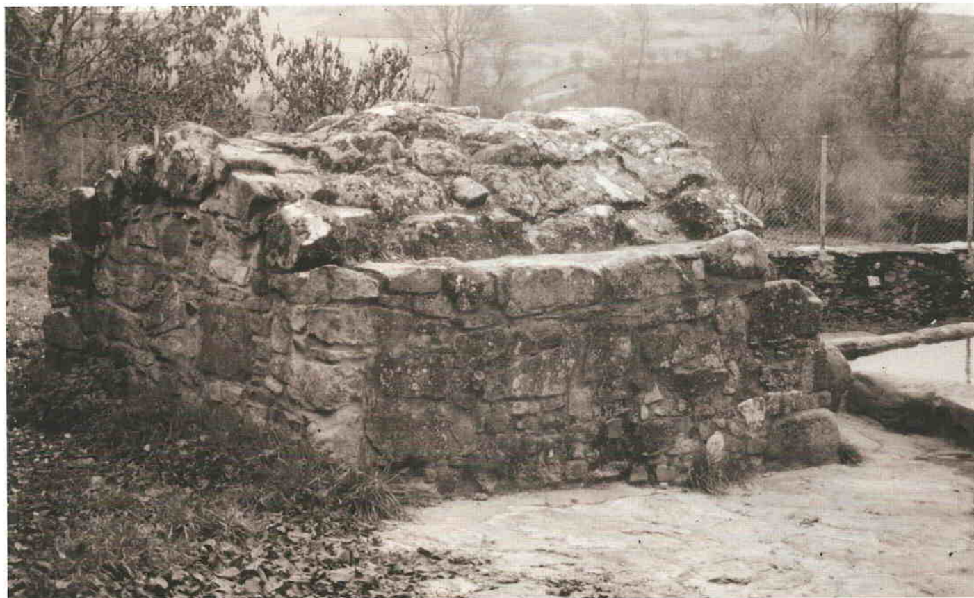
Nuez de Aliste: Fuente Grande. El descuidado trasdós de la bóveda, que contrasta notablemente con el intradós, hace suponer que el proyecto originario incluía una techumbre a dos aguas.
