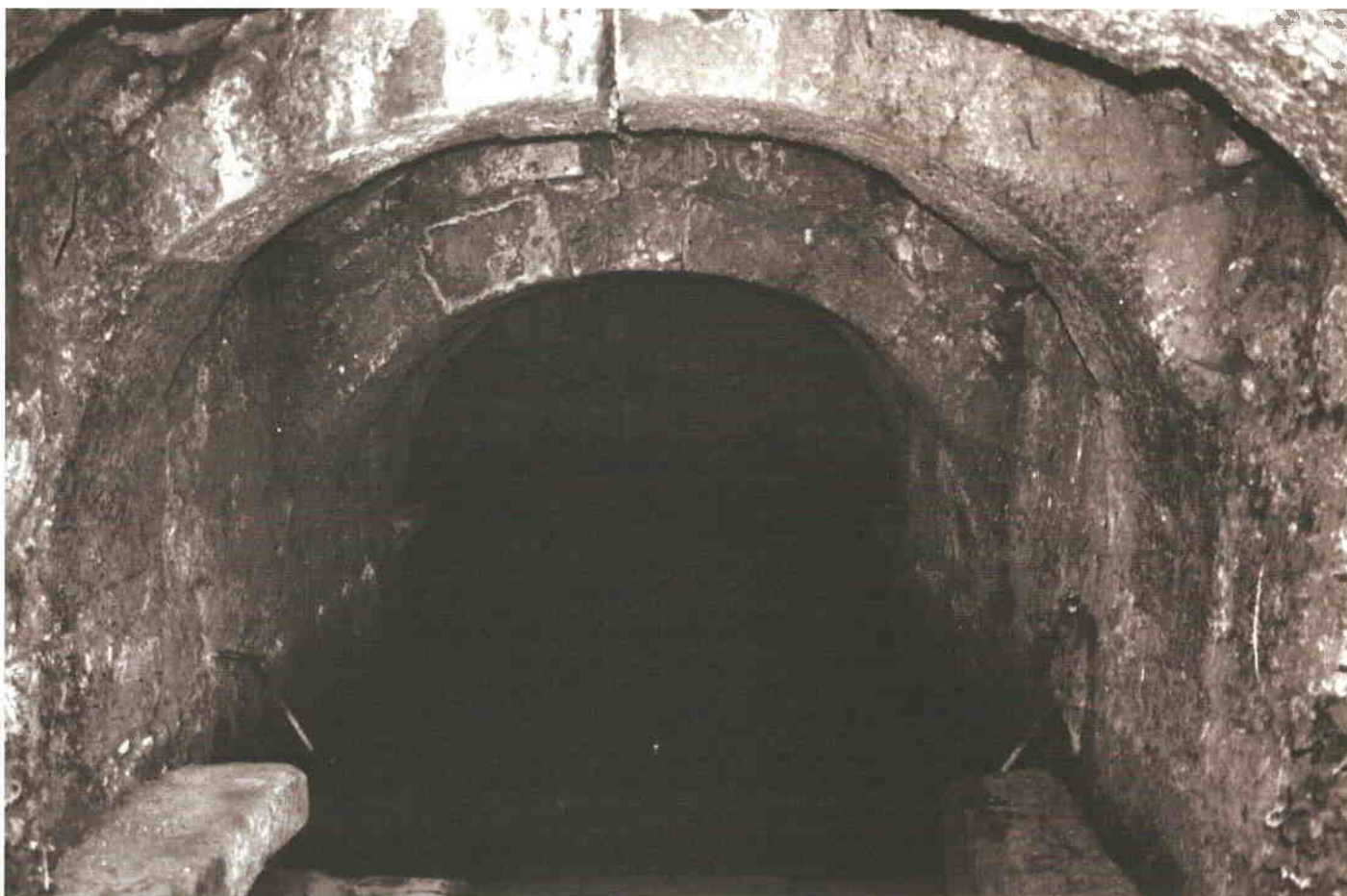
Famoselle: Fuente la Noria. Exterior y cámara abovedada con arcos fajones.
