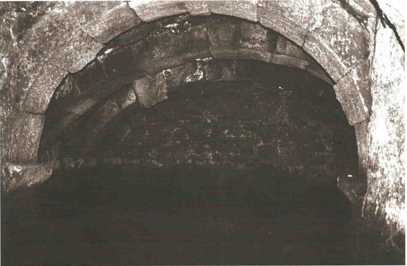
Fermoselle: Fuente la Noria. Detalle de los arcos fajones de la cámara.
