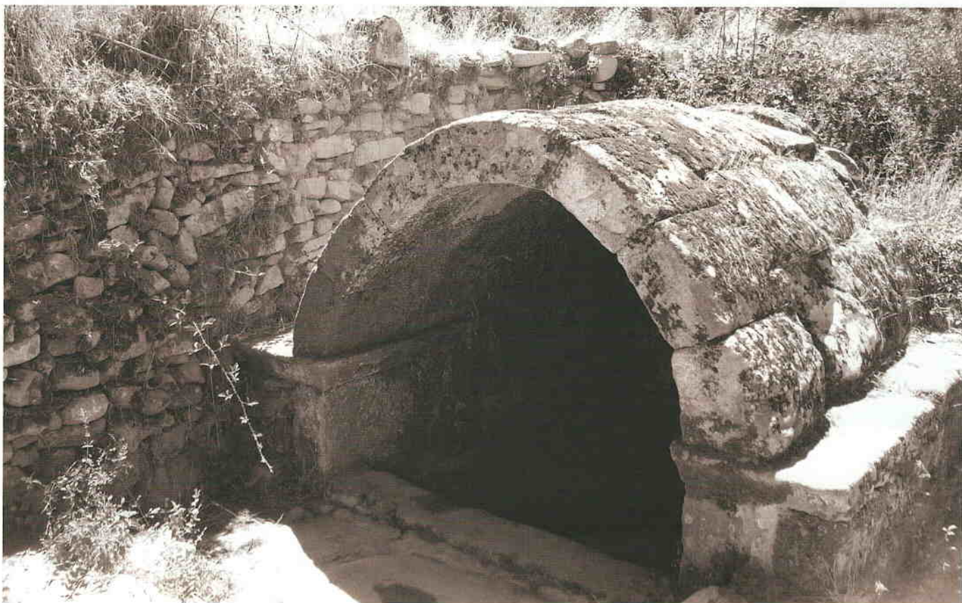
Fornillos de Fermoselle: La Pocera (antes y después de la rehabilitación).
