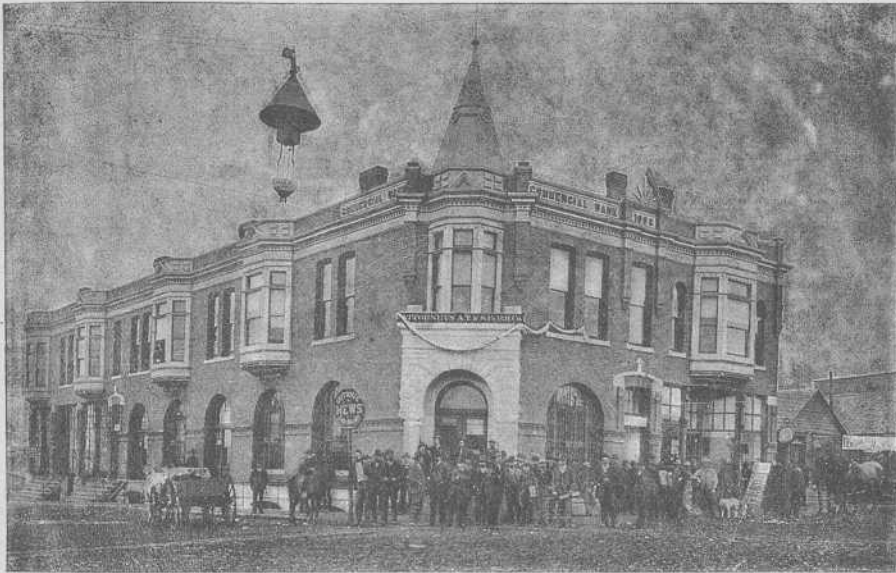
Una de las tres casas de piedra de Guthrie en 1890, La Commercial Bank
