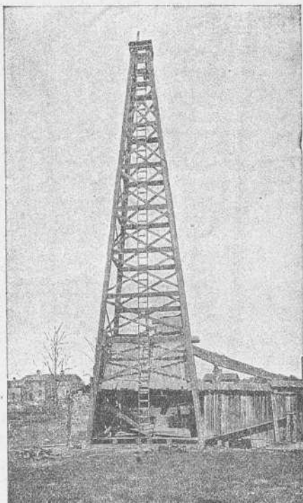
Pozo de gas natural en Cannonsburg, cerca de Pittsburgo
