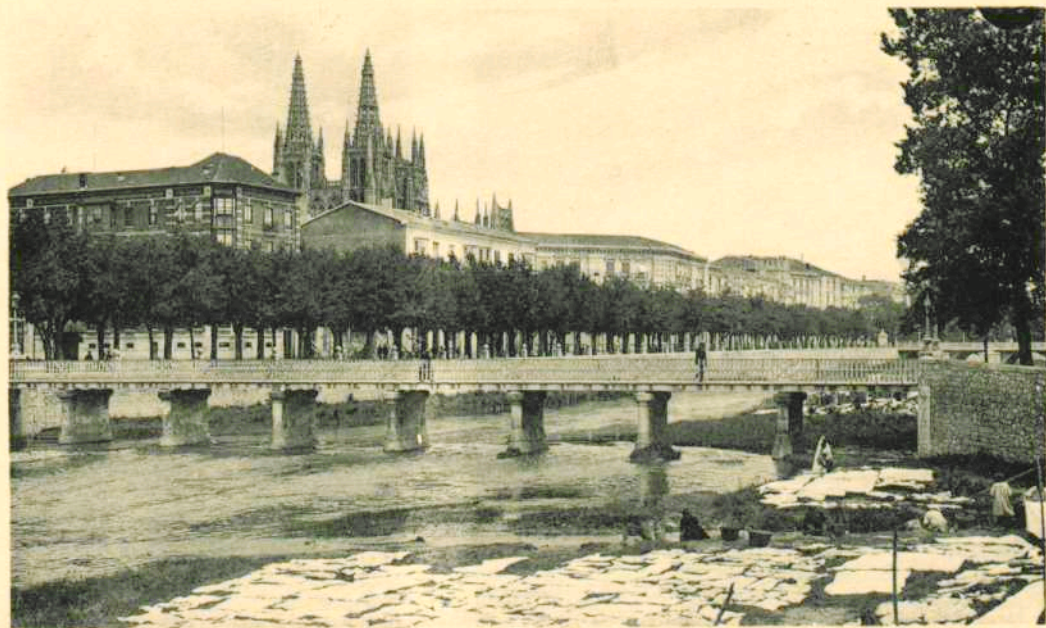
6. PUENTE DE BESÓN.
