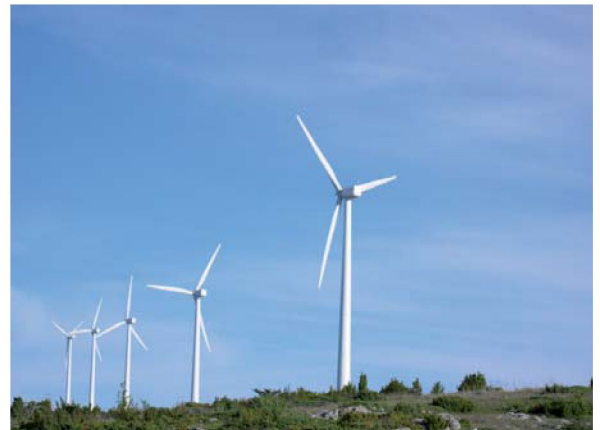
Parque eólico Poza de la Sal. Burgos.
