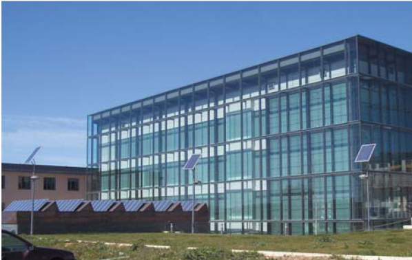
Edificio EREN. León.
