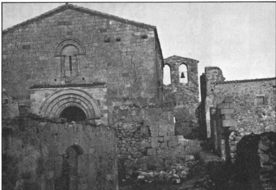
La ermita se encuentra en el vértice de una roca suspendida a más de cien metros sobre el río Duratón.
