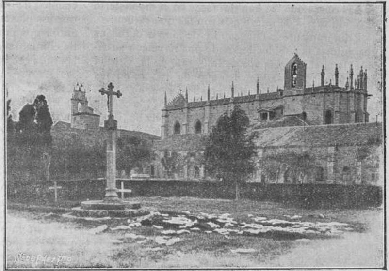
CARTUJA DE MIRAFLORES (BURGOS).—VISTA GENERAL.
