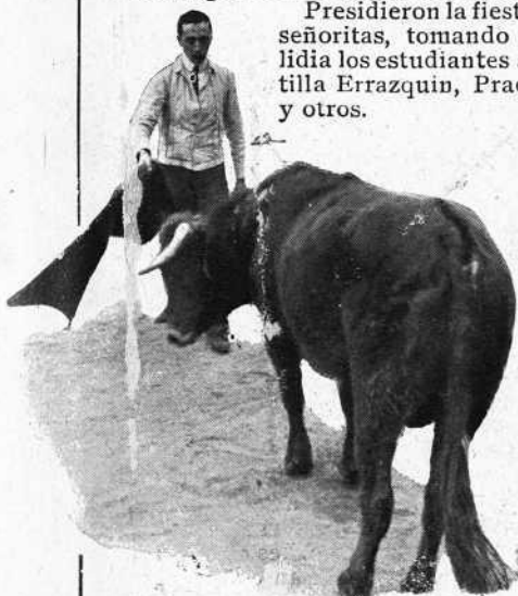
BILBAO. D. ANTONIO DE ERRAZQUIN MATANDO EL TERCER BECERRO
