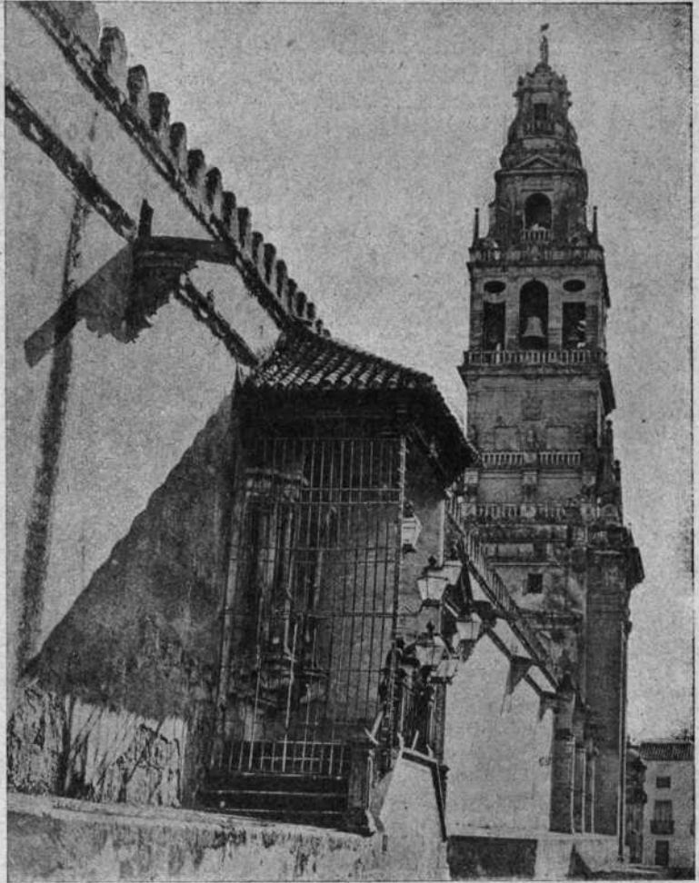
Torre y calle del Perdón.
