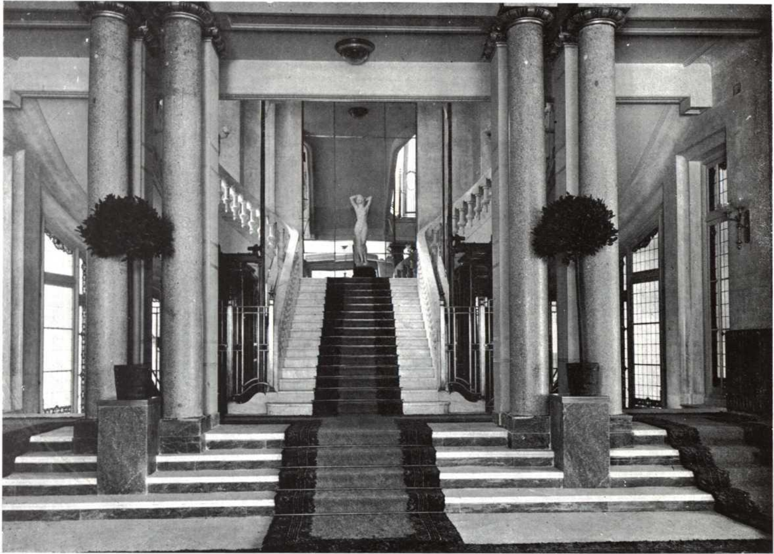
PRIMER TRAMO DE LA ESCALERA PRINCIPAL
