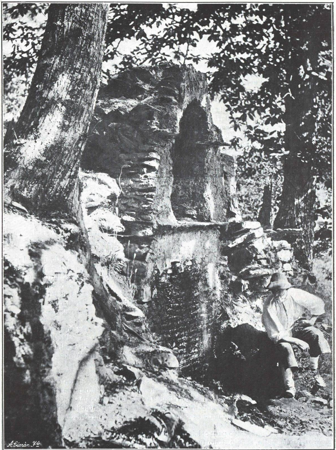
La fuente de las Conferencias. (Estado actual.)
