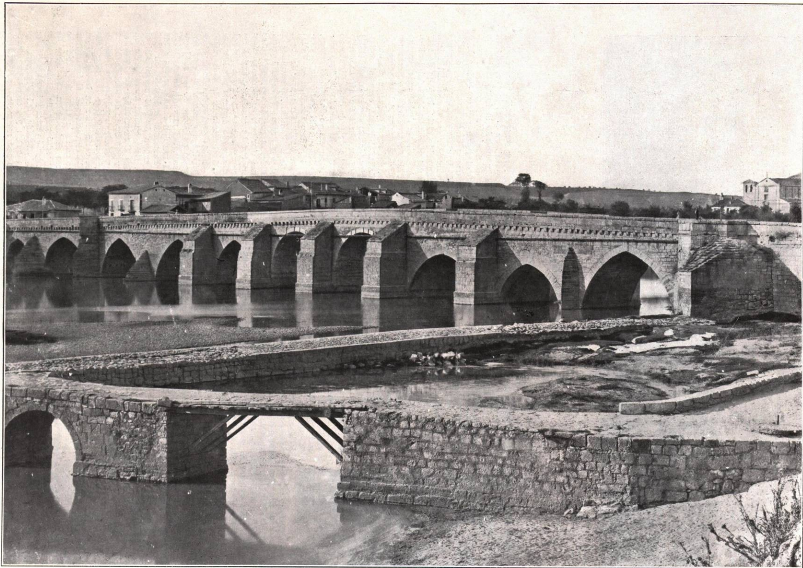
VISTA DEL PUENTE DE PIEDRA (VALLADOLID)
