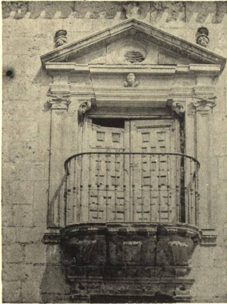
Balcon de la fachada pral.
