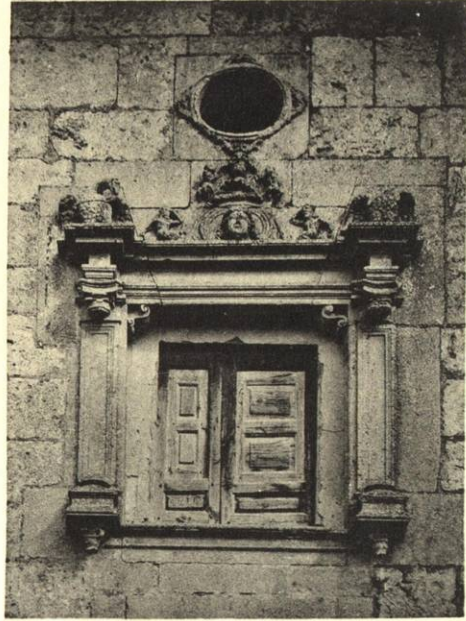
Ventana de la fachada lateral de la izquierda
