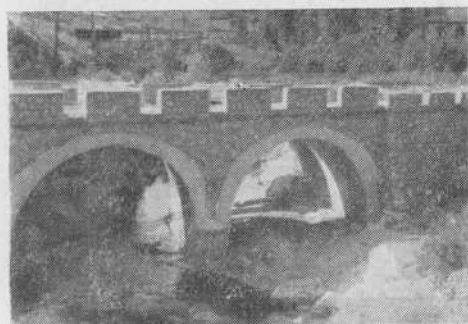
El puente de Campos, situado en la carretera Adanero Gijón. Se puede admirar una verdadera obra de ingeniería (F. García).
