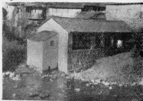
El lavadero Para la buena higiene y salud pública se le anexionó el water, sumando una obra más a las muchas de D. Victorino (F. García)
