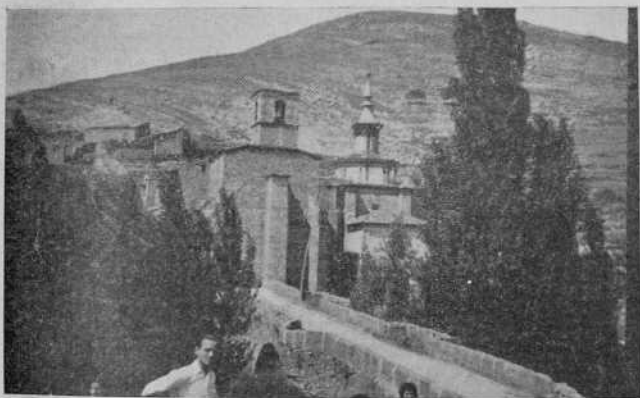
Iglesia de Santa María y puente sobre el Cidacos
