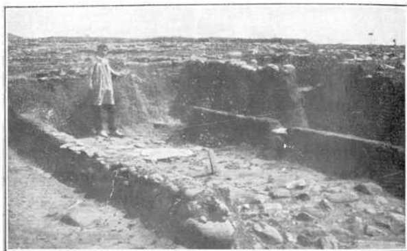
Fig. 39.—RESTOS DE UNA CASA IBÉRICA EN LA MANZANA III. (Foto Mérida.)
