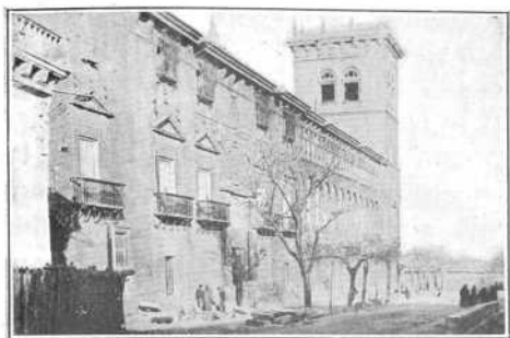
Fig. 17.—PALACIO DE GÓMARA. (Foto Ramirez.)
