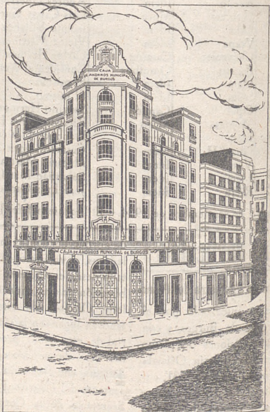
Oficinas donde está instalada la Caja de Ahorros Municipal, en Miranda de Ebro
