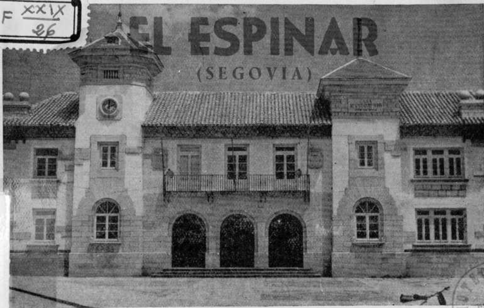
Fachada principal del Ayuntamiento
