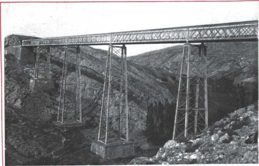
La más notable construcción moderna de Soria, distinguiéndose por la esbeltez y resistencia que ofrecen sus sencillos pilares.
