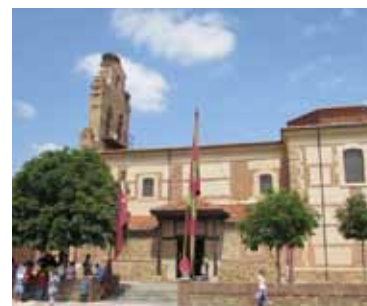
Iglesia de San Juan Bautista. Trobajo del Camino.
