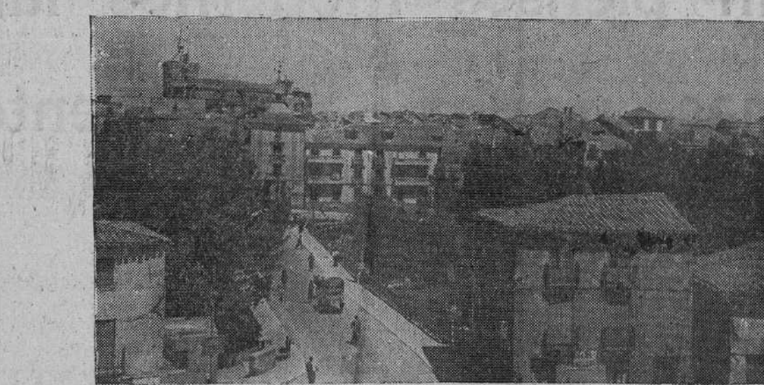
ENTRADA PRINCIPAL A LA VILLA, EN LA CARRETERA MADRID - IRUÑ
