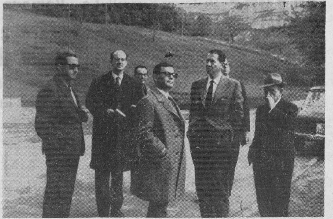
El presidente del Sindicato nacional del Combustible, don Víctor Arroyo, con las demás personalidades del séquito, se detienen en Quintanilla Escalada para examinar la marcha de los trabajos de la estación terminal de carga.
