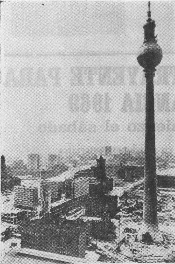
Está ya prácticamente terminada la gigantesca torre de la televisión, construida en el Berlín Oriental. Se quiere inaugurarla el 7 de Octubre, con ocasión del 20 aniversario de la fundación de la Alemania del Este.
