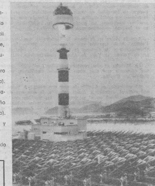
Nio, Kagawa-Ken (Japón). — Acumulando rayos solares reflejados en 807 paneles perfectamente coordinados, al aparato de concentración de calor de la torre central desprende luz sobre el cielo de la Planta de Energía Solar Nio. La Central, situada al Sudoeste de la isla de Shikoku, generó por primera vez 1.000 kilovatios de electricidad, la cantidad mayor de energía generada por una planta de este tipo en el Mundo. — (Telefoto EFE-AP).
